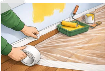
Защита поверхностей при малярных и покрасочных работах
