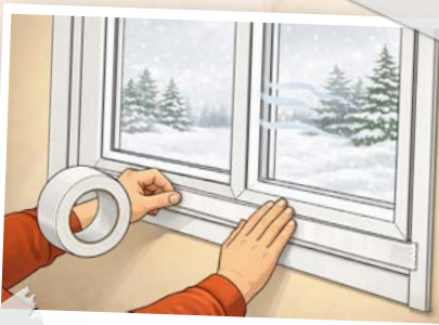
Заклеивание окон на зиму
